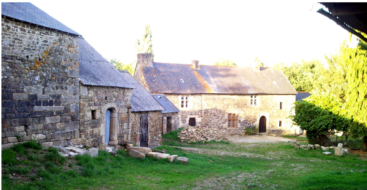
Façade sud Etat actuel.
