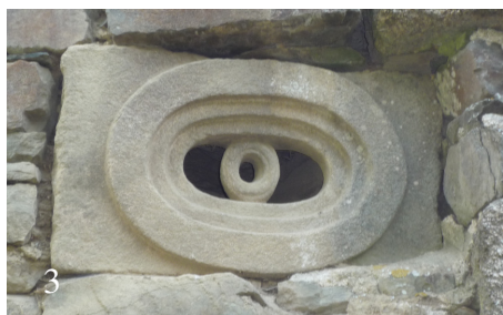
DE HAUT EN BAS Photo 1 - Façade nord avec tour d'escalier semi-hors-œuvre Photo 2 - Reprise de l'ancienne maçonnerie par une « trompe archaïque ». Photo 3 - Trou de guetteur de la chambre haute dans le pignon ouest.
