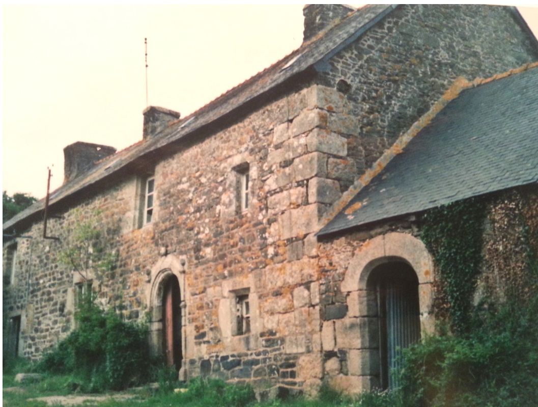
Façade sud Avant travaux
