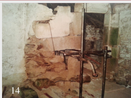
14 Pendant les travaux : Etaisement des pierres de taille
