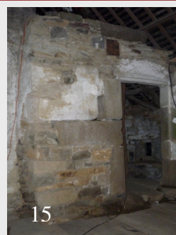
15 Après travaux de réfection
